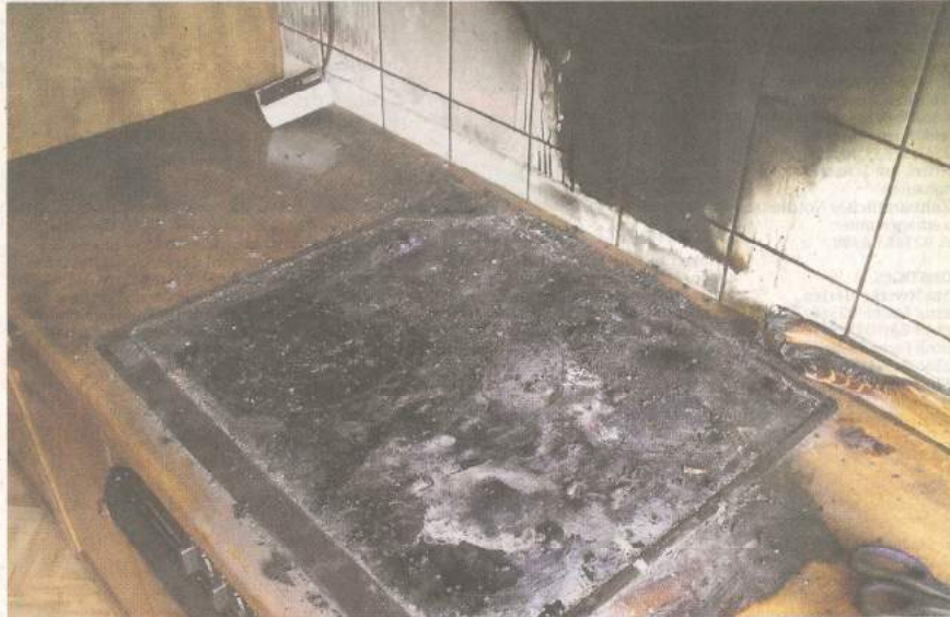
Ein Bild der Verwüstung: Essen ist auf dem eingeschalteten Herd vergessen worden. Irgendwann sind die verkohlten Speisereste in Brand geraten und das Feuer hat auf die Küche übergreifen. –FOTO: FEUERWEHR HERTEN
