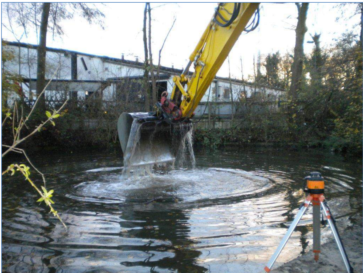
Entschlammung des Löschteiches bei Schneider in der Ried
