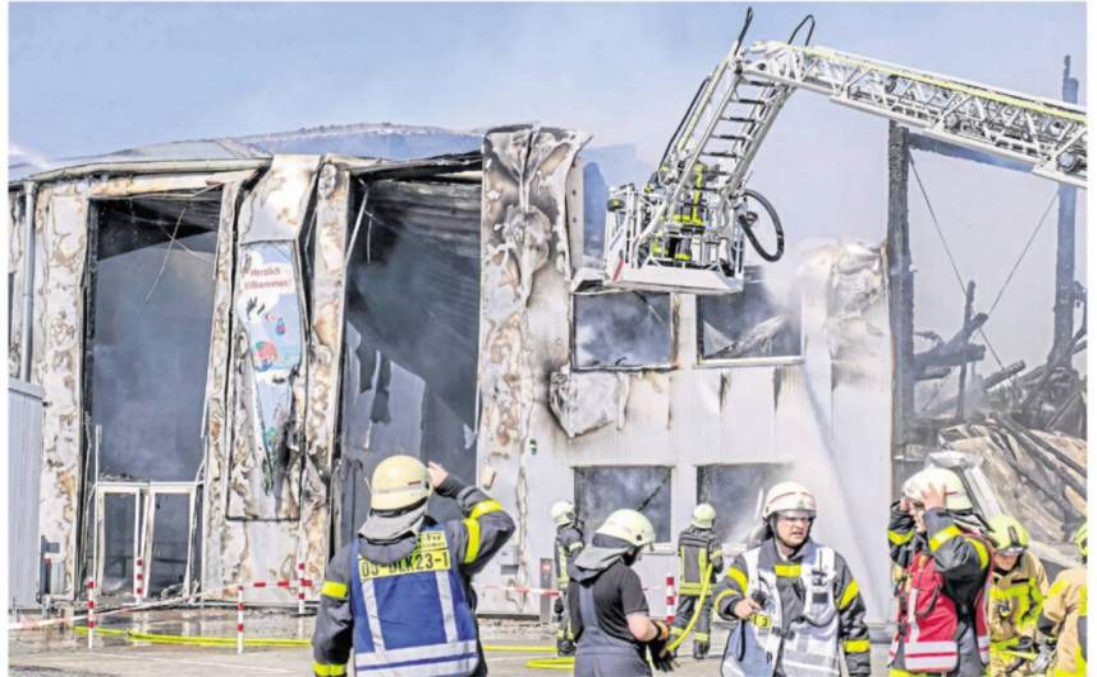
Aussichtsloser Kampf gegen die Flammen: Über Stunden ist die Feuerwehr an der „Kinderwelt“ im Einsatz, immer wieder stürzen Teile der Dachkonstruktion und der Fassade ein. Feuerwehr-Dezernent Ekkehard Grunwald, der als Vertreter von Bürgermeister Christoph Tesche die Brandstelle inspiziert, hofft darauf, „dass diese sehr stark frequentierte Attraktion für Kinder wiederaufgebaut wird – auch wenn es Monate dauern kann.“ –FOTOS: GUTZEIT
