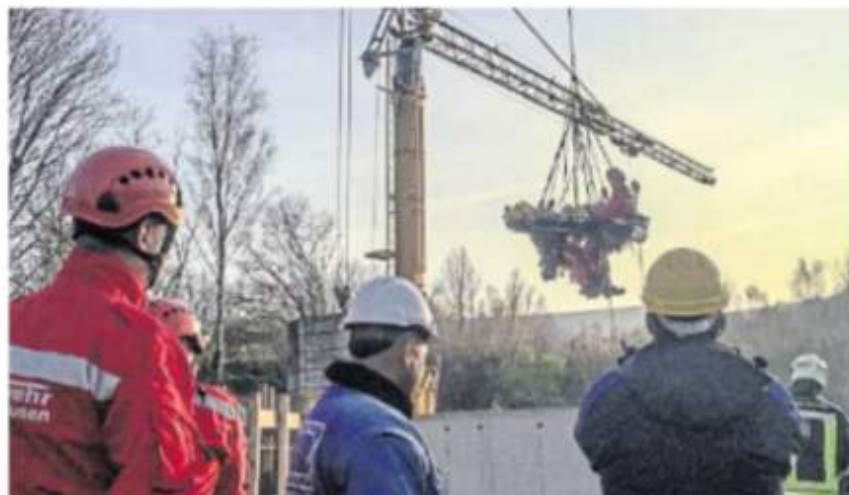
Mithilfe eines Baukrans bringen die Höhenretter hier den Verunglückten aus 17 Metern Tiefe nach oben. —FOTO: DM
