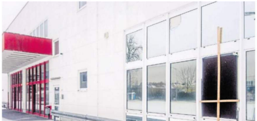
Im leer stehenden Gebäude des alten toom-Baumarkts gab es am Wochenende einen Einsatz der Feuerwehr. Hier hatte die Brandmeldeanlage ausgelöst. —FOTO: (ARCHIV) MAISS
