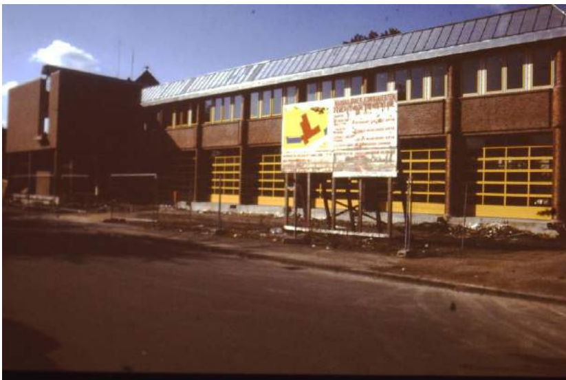
Der fast fertige Rohbau der Feuer- und Rettungswache
