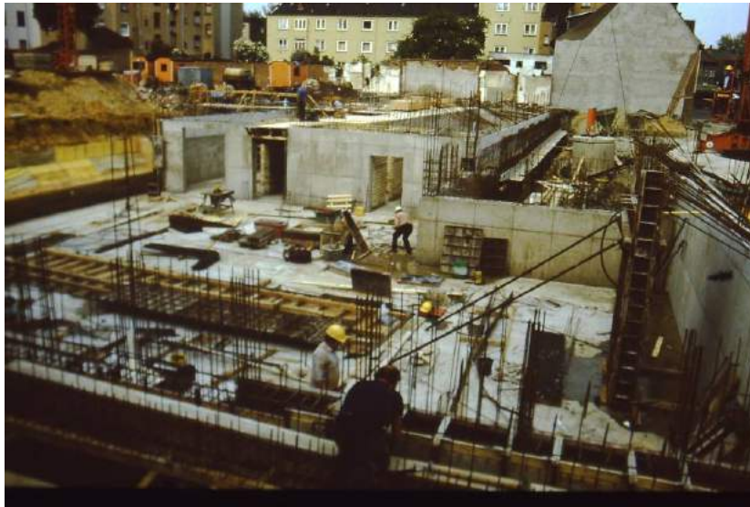
Errichtung Kellergeschoss
