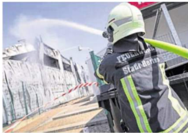
Einsatzkräfte der Feuerwehr Herten löschen das Gebäude der „Kinderwelt“.
