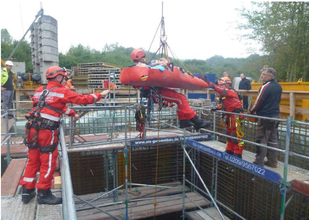
Rettungseinsatz Schachtbauwerk Emscherzulauf, Hohewardstr. (nähe A2)
